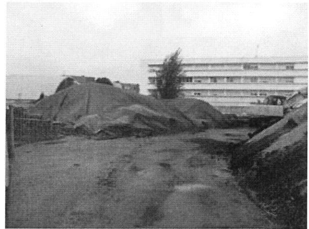
Matériaux en attente d'évacuation
