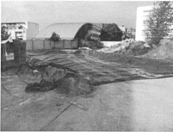
Aire de stockage des sols pollués
